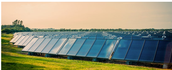
Exemple de centrale solaire thermique de grande taille alimentant en chaleur des procédés industriels
