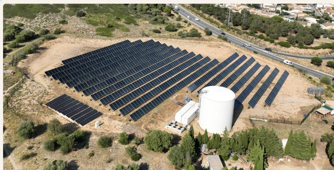
Intégration d'une chaudière électrique de 1MW à notre centrale solaire thermique et stockage thermique alimentant le Réseau de Chaleur de la ville de Narbonne
