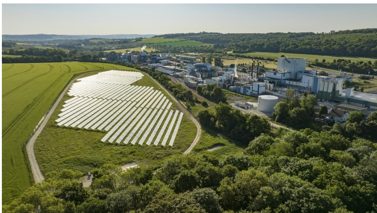
Centrale solaire thermique LACTOSOL, qui alimente le site Lactalis de Verdun ( Photos HD )
