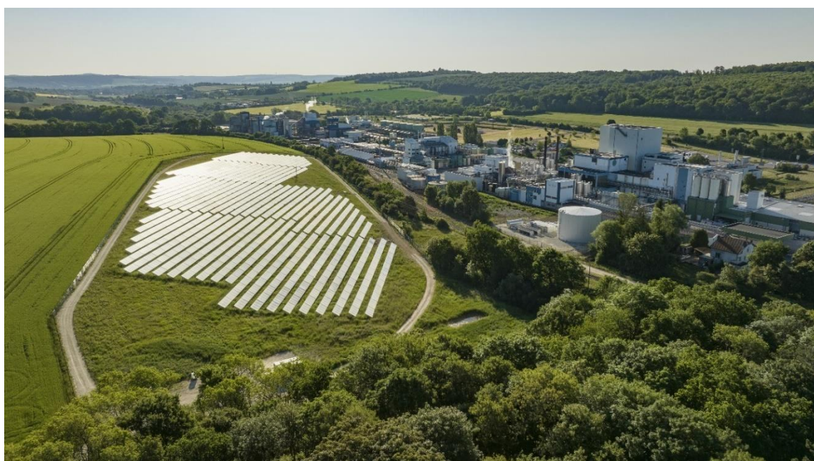
Centrale solaire thermique LACTOSOL, qui alimente le site Lactalis de Verdun ( Photos HD ) Photos : IMAGESinAIR Productions à Epernay
